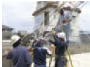
山二ツラジオ送信所の工事（新潟市）
