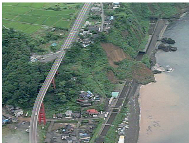
土砂崩れて不通となったJR信越本線 (青海川駅付近)
