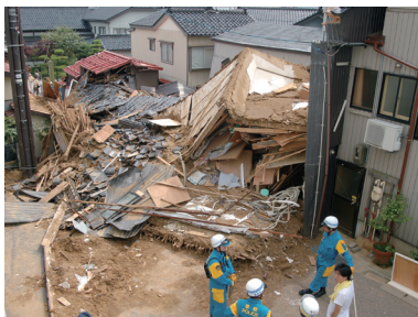
倒壊した家屋（柏崎市内）
