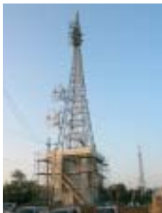
小出デジタルテレビ中継局建設工事
